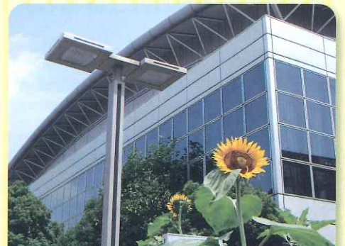
高津スポーツセンター
